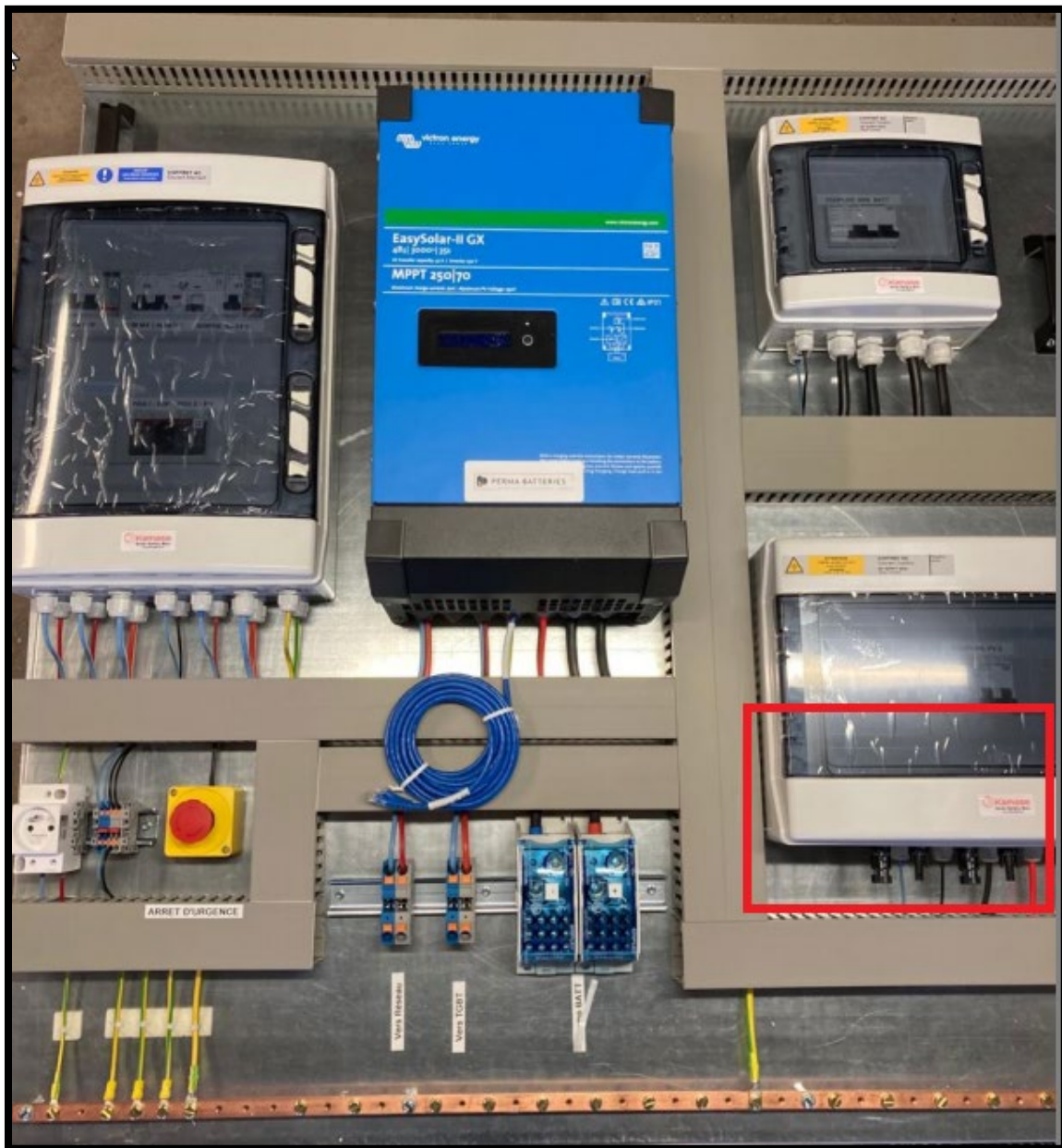
Emplacement du coffret « solaire » sur la platine
