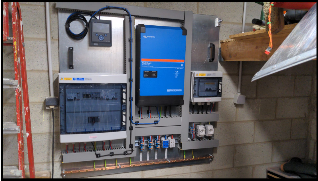
Exemple d'une platine SUN.CONNECT 5000 fixée
