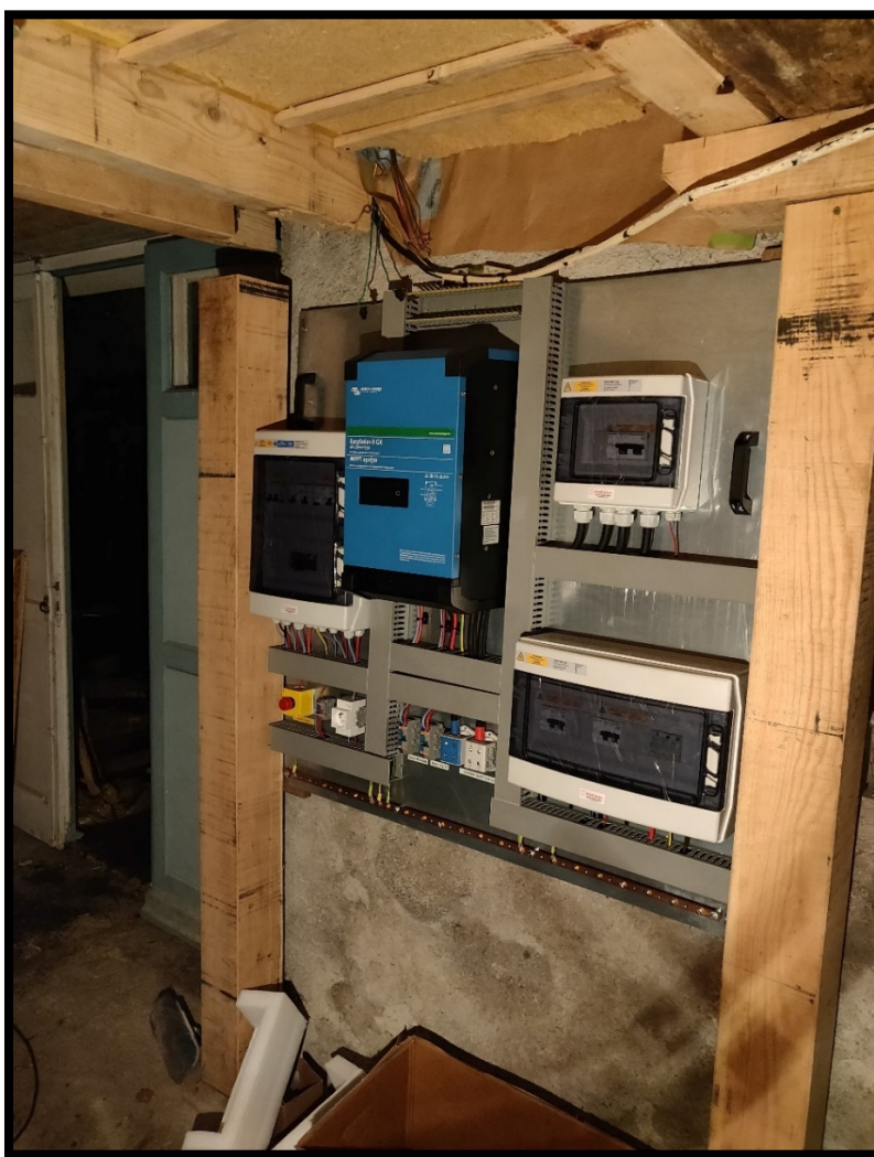
Exemple d'une platine SUN.CONNECT 3000 fixée au mur
