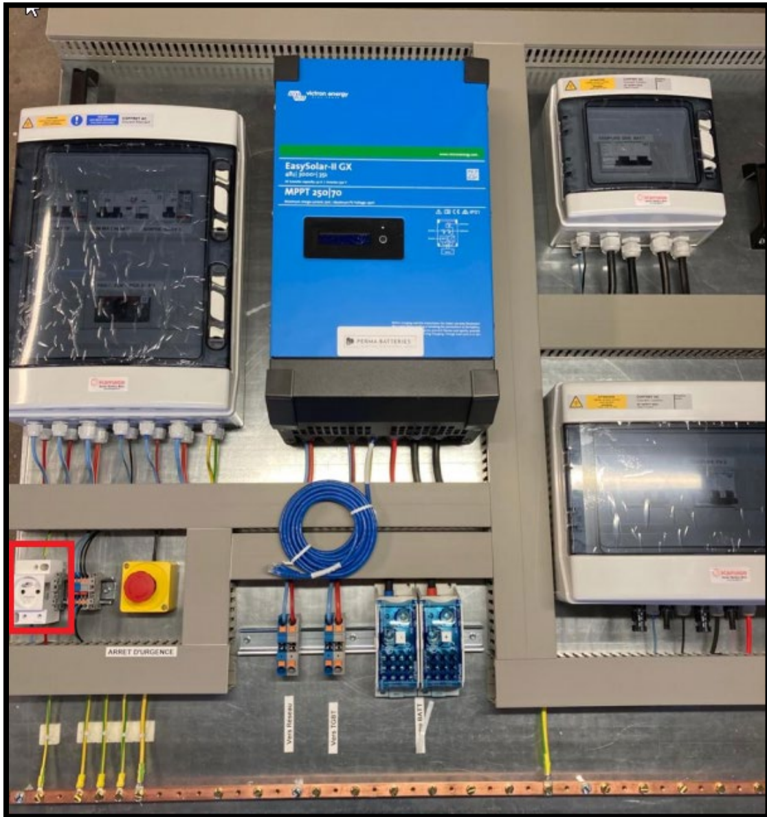
Localisation de la prise 16A sur la platine SUN.CONNECT (en bas à gauche en rouge)
