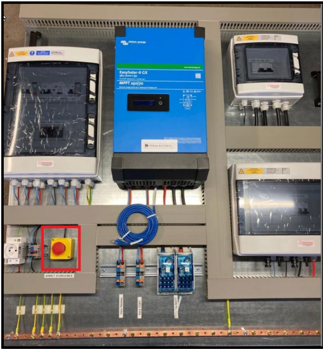
Représentation de la coupure d'urgence sur la platine
