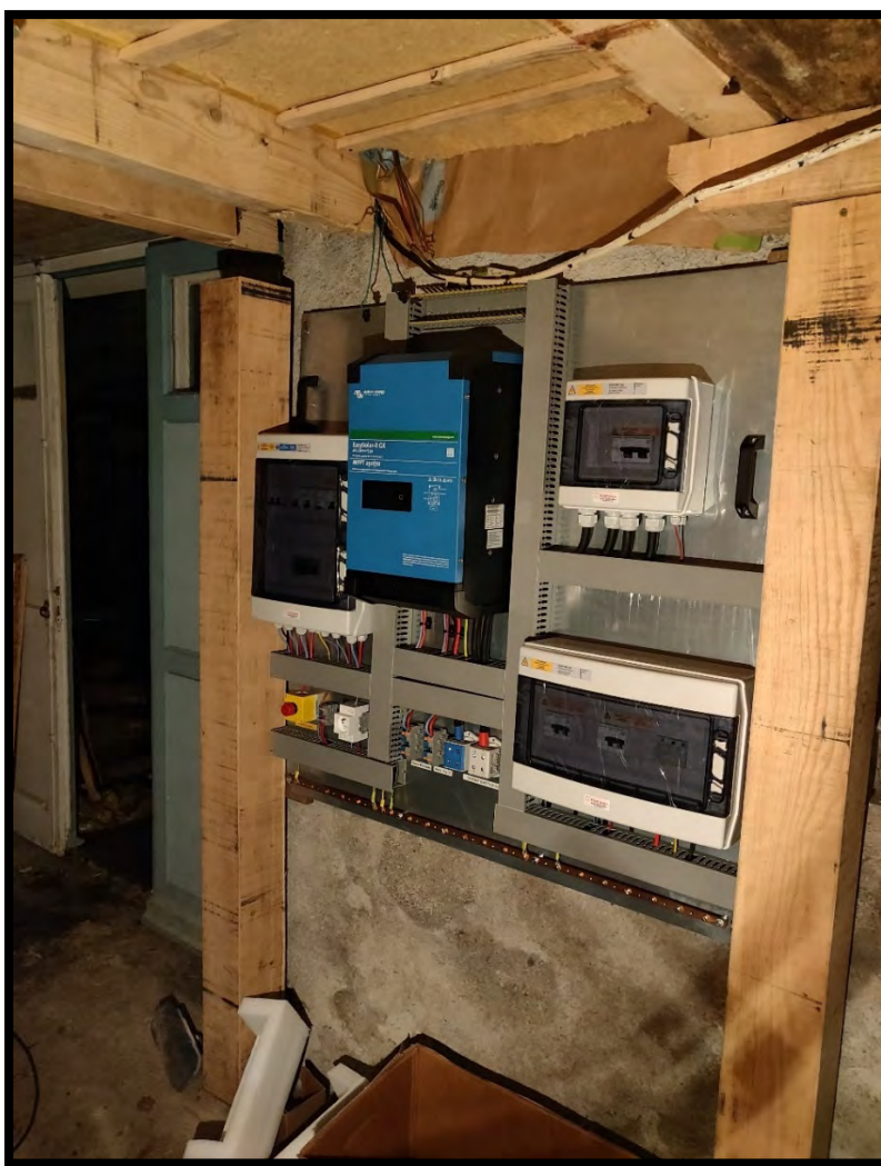
Exemple d'une platine SUN.CONNECT 3000 fixée au mur
