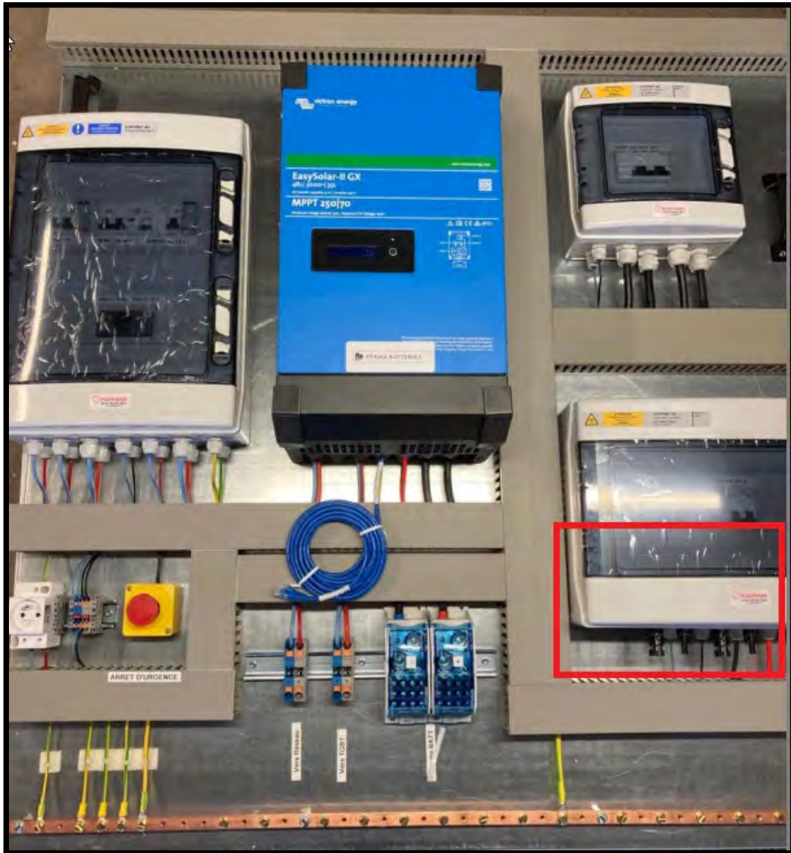
Emplacement du coffret « solaire » sur la platine
