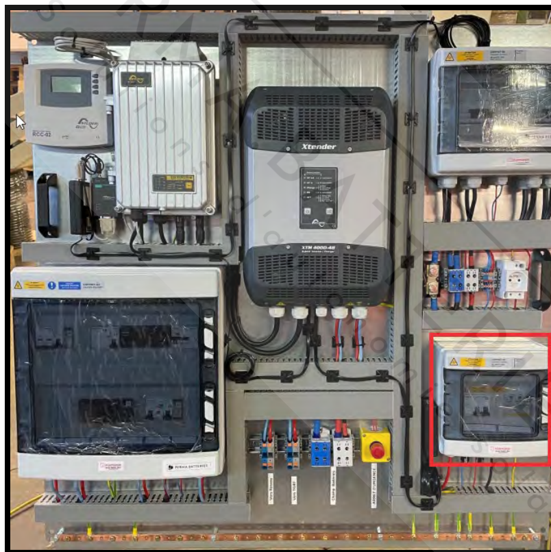
Emplacement du coffret « solaire » sur la platine
