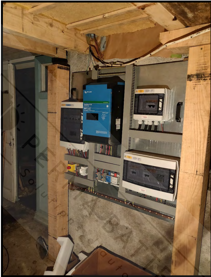
Exemple d'une platine SUN.CONNECT 3000 fixée au mur
