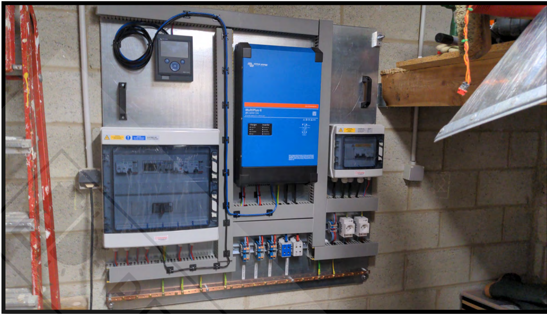
Exemple d'une platine SUN.CONNECT 5000 fixée
