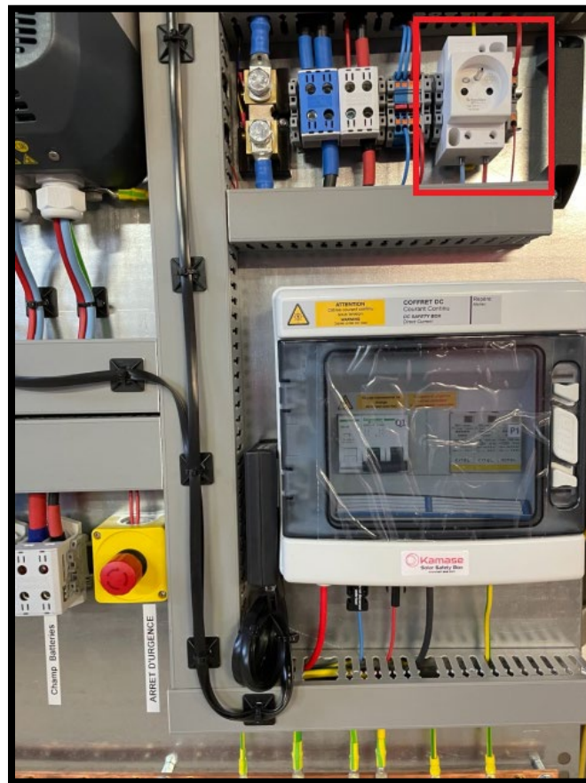
Localisation de la prise 16A sur la platine SUN.CONNECT
