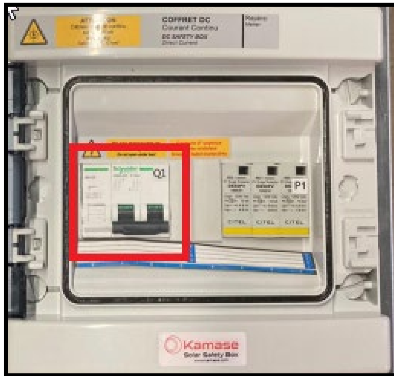
Disjoncteur de coupure des panneaux solaires Q1.
