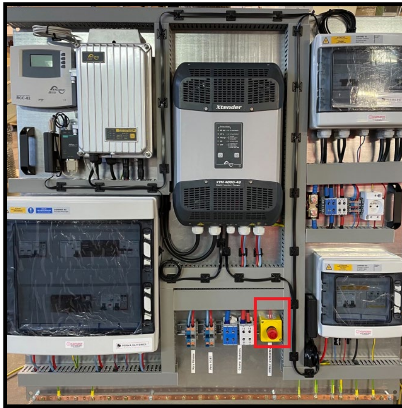
Représentation de la coupure d'urgence sur la platine
