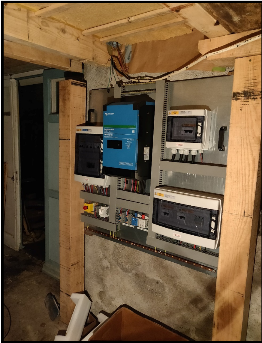
Exemple d'une platine SUN.CONNECT 3000 fixée au mur
