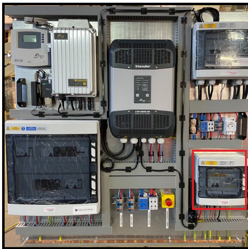
Emplacement du coffret « solaire » sur la platine
