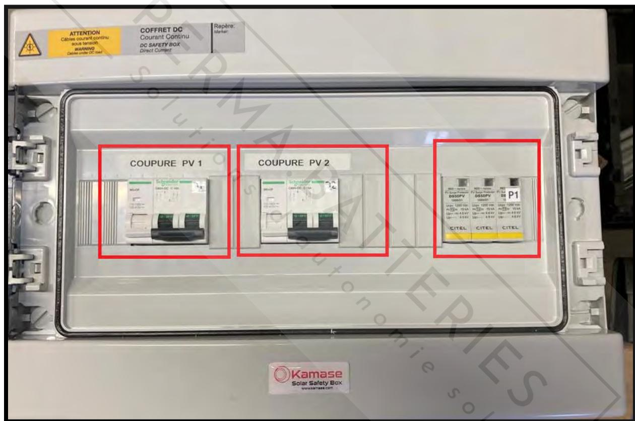
Coffret DC. Les deux disjoncteurs sur la gauche protègent chaque groupe de panneaux solaire et permet leur déconnection si nécessaire du système (en cas de maintenance).
