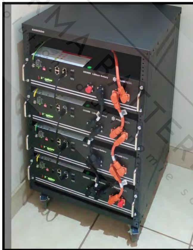
Chaque batterie doit être reliée à la suivante via le câble de terre vert-jaune fourni, et la dernière batterie sera reliée à la terre de la platine SUN.CONNECT via la barrette de cuivre.
