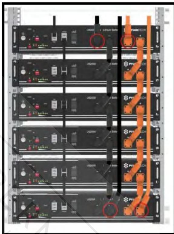
Une fois les batteries branchées conformément aux instructions, il faut connecter le BMS de la batterie dite « maître » (la première de la pile) au système de gestion Victron, le Color Control GX. Un câble RJ45 spécifique est prévu à cet effet de ce type :
