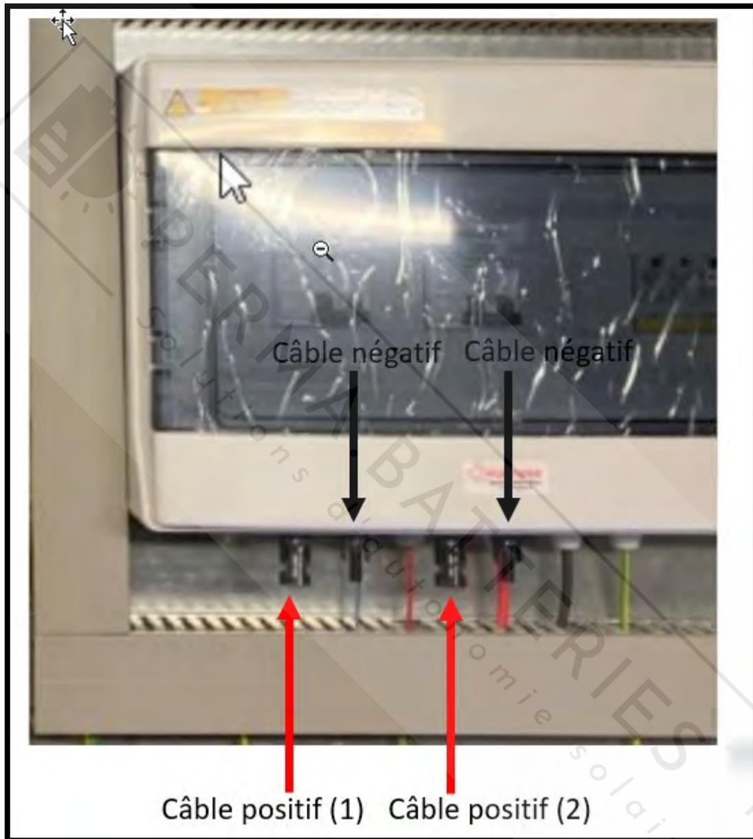
Coté panneaux solaires, **ces derniers doivent être reliés en deux chaînes de 5x panneaux en série** (si 10x panneaux sont présent), ou en une seule chaîne unique de 5x panneaux (si seulement 5x panneaux solaires sont présent), de la manière suivante :
