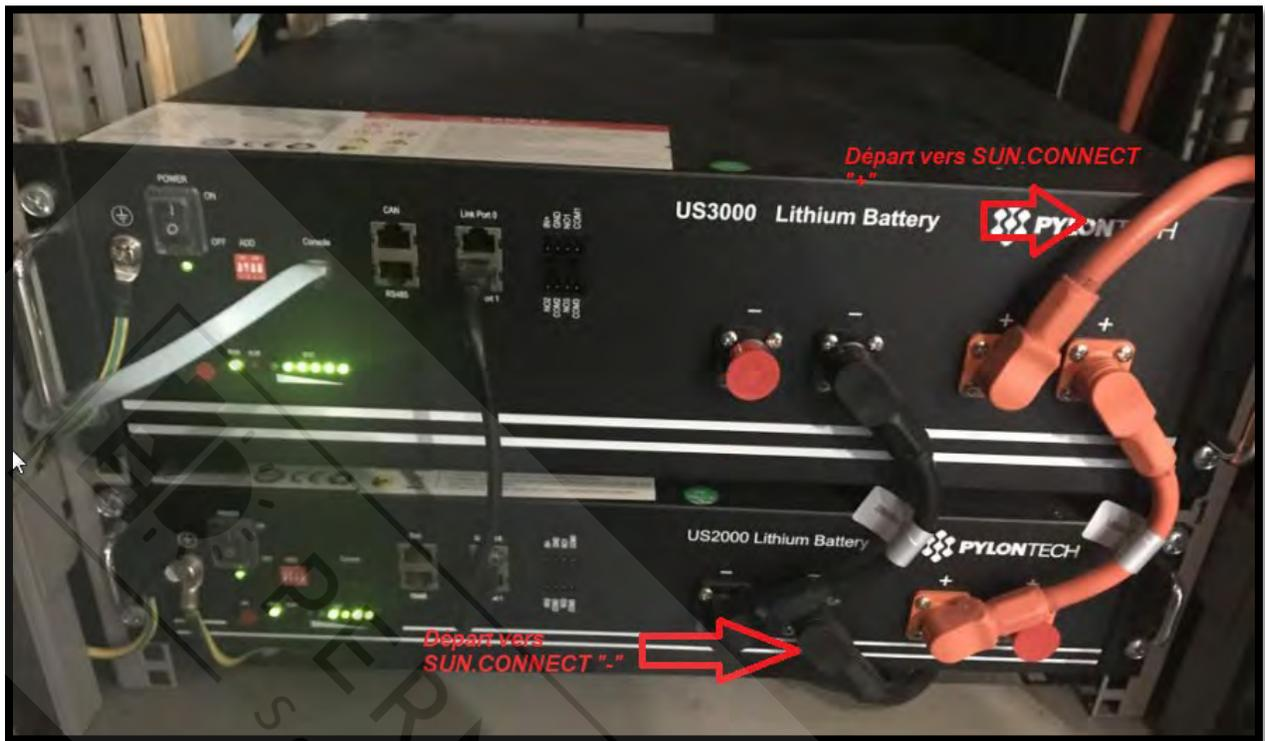
Exemple de branchement de deux batteries Pylontech. Les départs vers les borniers se font sur la droite, via les câbles orange et noirs fléchés.
