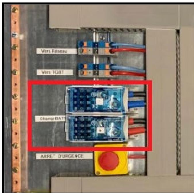
Bornier « CHAMP BAT » pour la connection des batteries au système. Le bornier ERICO accepte des câbles nus dénudés de section 25-35mm<sup>2</sup> :
