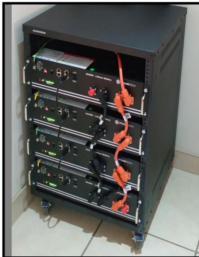
Chaque batterie doit être relié à la suivante via le câble de terre vert-jaune fourni, et la dernière **batterie sera relié à la terre de la platine SUN.CONNECT via la barrette de cuivre.**
