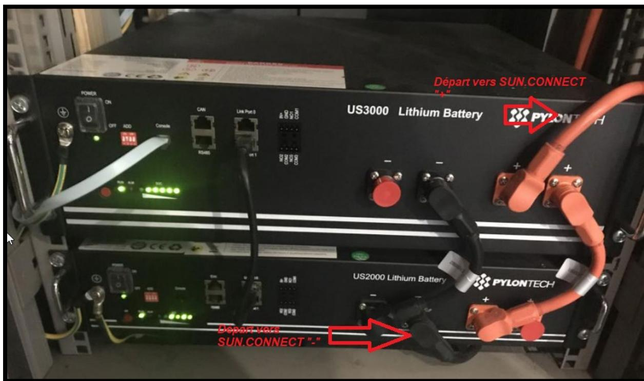
Exemple de branchement de deux batteries Pylontech. Les départs vers les borniers se font sur la droite, via les câbles orange et noirs fléchés.
