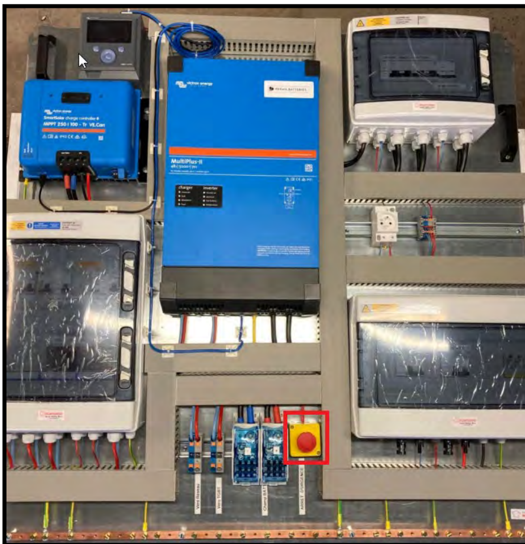
Représentation de la coupure d'urgence sur la platine
