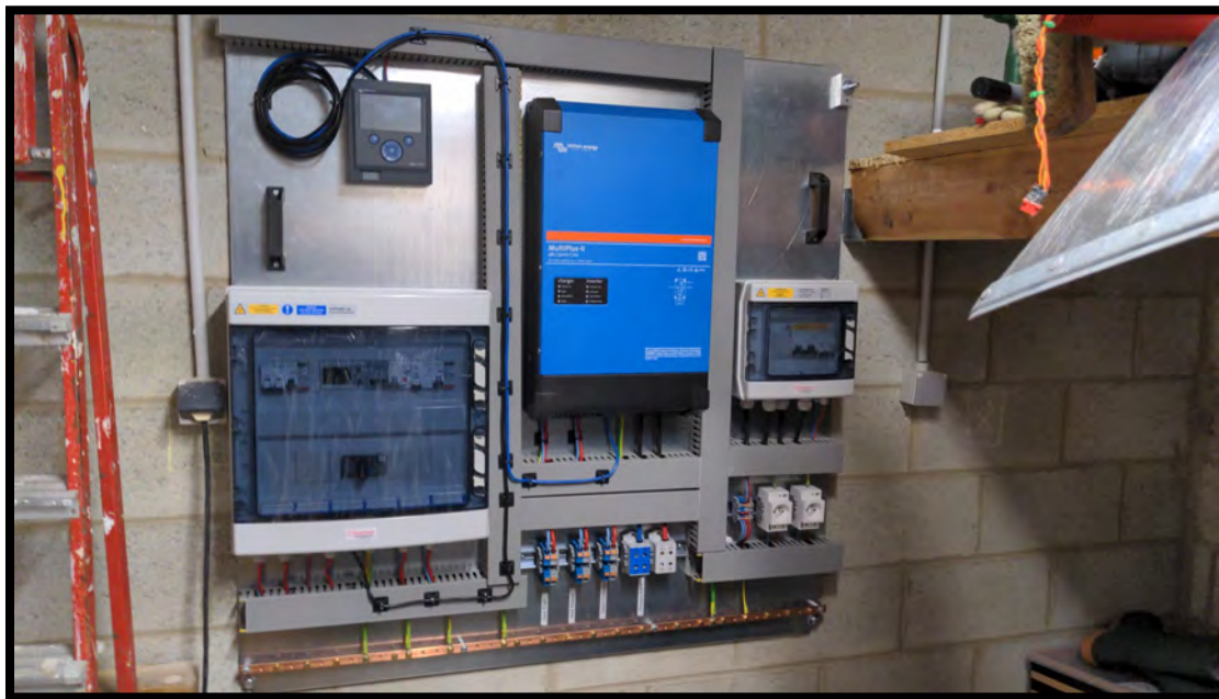
Exemple d'une platine SUN.CONNECT 5000 fixée
