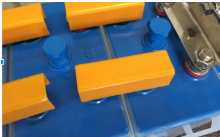
Fig.9. Mise en place des plaques isolantes pour les bus-bar d'inter-jonction.
