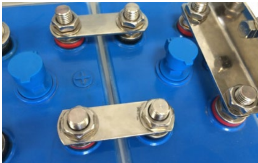
Fig.9. Mise en place des plaques d'inter-connexions.
