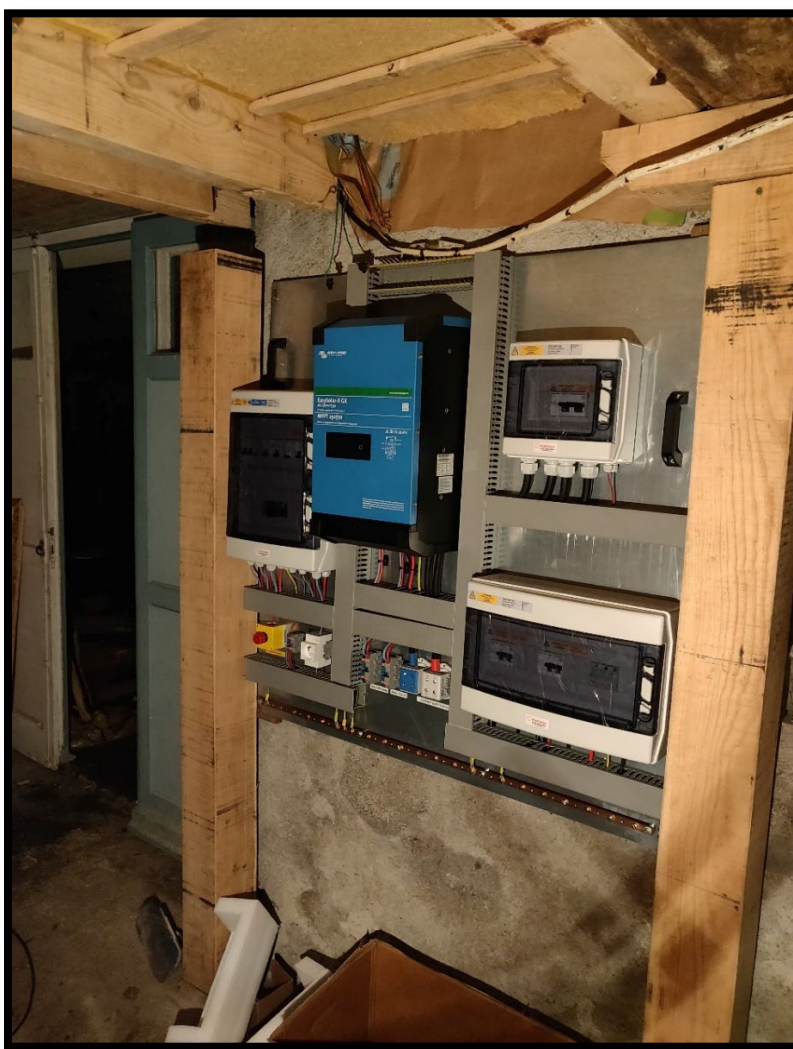
Exemple d'une platine SUN.CONNECT 3000 fixée au mur
