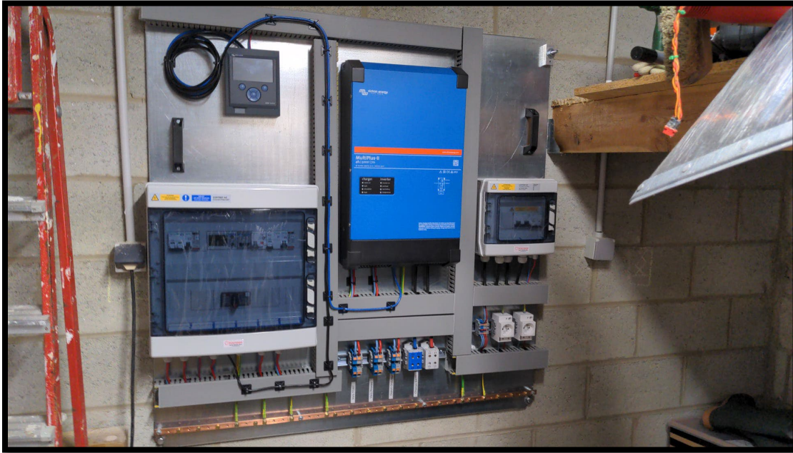
Exemple d'une platine SUN.CONNECT 5000 fixée
