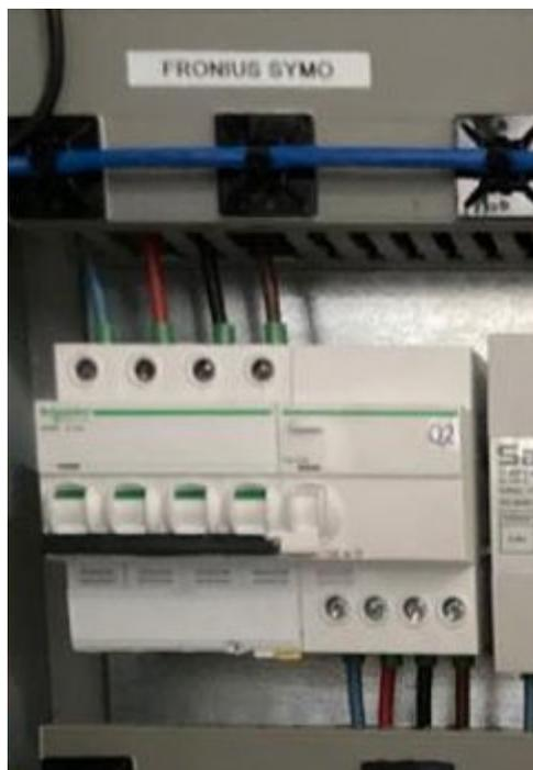
**Ne pas oublier de fermer le sectionneur situé sous l'appareil**, en le tournant dans le sens **des aiguilles d'une montre (position I)** : Cela a pour effet d'alimenter le Fronius en courant continu depuis le champ photovoltaïque.
