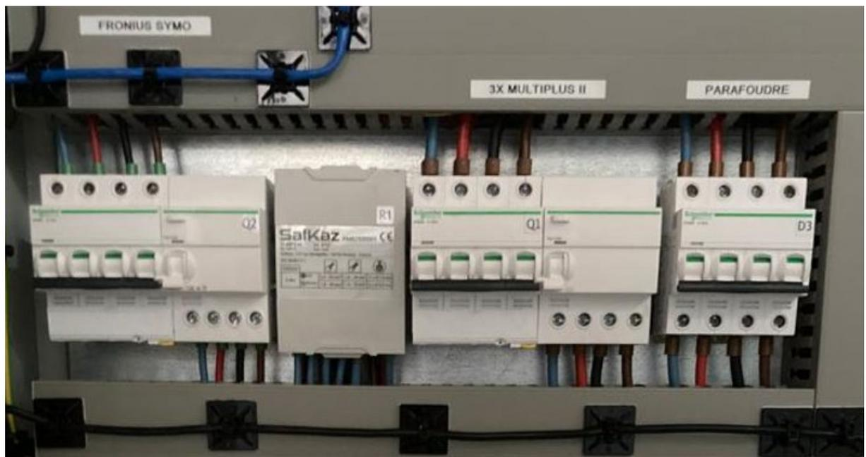
Armer également le disjoncteur pilotant la ventilation forcée, « D2 » :
