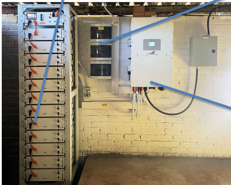
Exemple 1 : 30KVA et 12x modules batteries (65 kWh)
