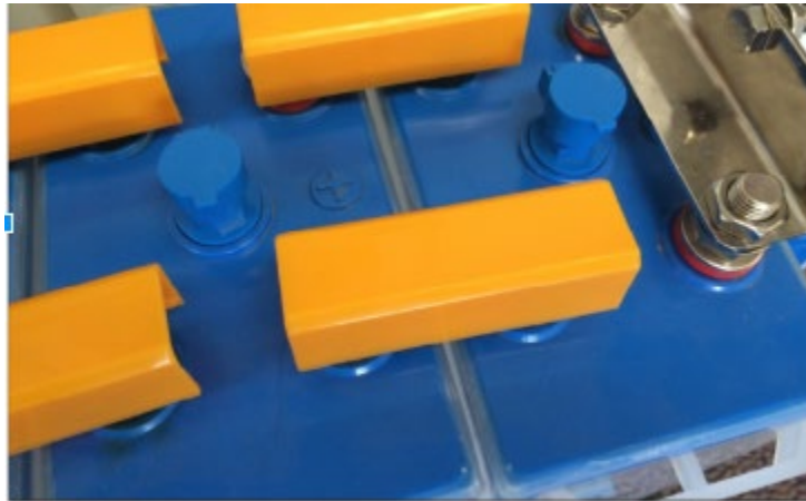
Fig.9. Mise en place des plaques isolantes pour les bus-bar d'inter-jonction.
