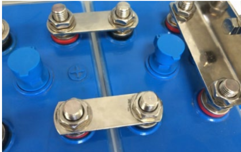
Fig.9. Mise en place des plaques d'inter-connections.
